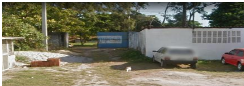
Figura 5 – Estação de Tratamento de Esgoto – COMPESA. Fonte: Google
