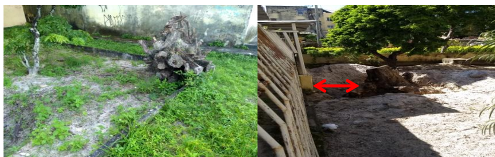
Figura 15 – Supressão de vegetais que interferem nas fundações dos edifícios.
