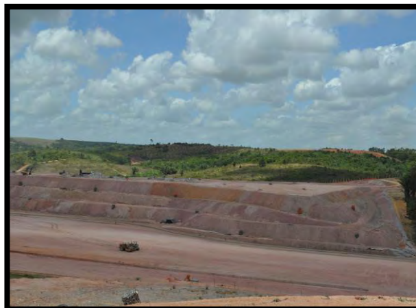
Figura 2. Disposição de resíduos sólidos em camadas no Aterro Sanitário CTR candeias. Fonte: CTR candeias, 2010.
