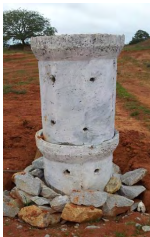
Figura 11. Dutos de exaustão. Fonte: Cabral Neto (2012).
