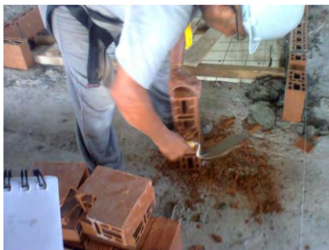
Figura 6. Pedreiro da Obra A quebrando bloco de 9x19x39 cm antes de utilizá-lo. Fonte: os autores (2014).
