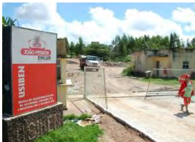
Figura 4. Usina de Beneficiamento de resíduos da construção civil. Fonte: Site da Prefeitura Municipal de João Pessoa (PMJP).
