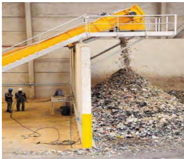
Figura 2. Processo de peneiramento. Fonte: Portal de Paulinia (2014).
