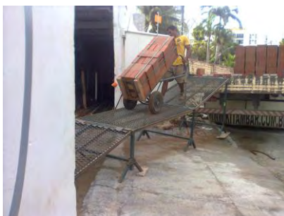
Figura 5. Blocos sendo descarregados na Obra A. Fonte: os autores (2014).
