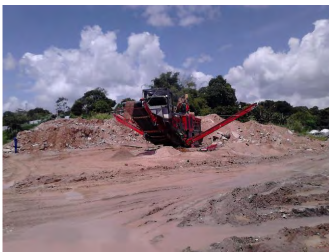
Figura 3. Britadeira utilizada na obra. Fonte: Os autores (2014).
