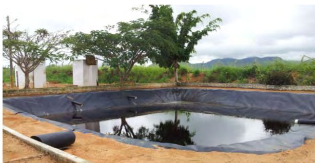
Figura 10. Piscina de tratamento do chorume. Fonte: Cabral Neto (2012).
