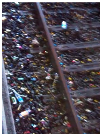
Figura 3. Demonstrativo do lançamento indevido de resíduos na via pelos usuários. Fonte: os autores (2014).
