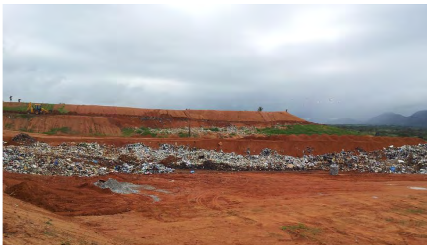
Figura 8. Área de aterramento C03. Fonte: Cabral Neto (2012).
