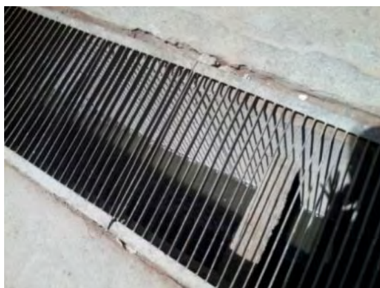
Figura 3: Direcionamento da lama para tanques de decantação.
