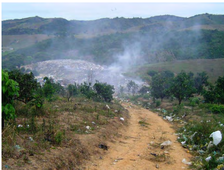
Figura 4 – Vista da topografia irregular do terreno. Fonte: os autores (2014)
