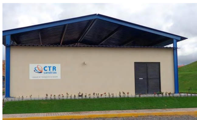
Figura 4. Unidade de Tratamento de Biogás vista Frontal. Foto: CT-Candeias (2014).
