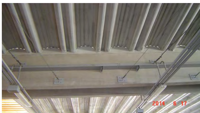
Figura 06 – Vedação dos espaços das telhas como estratégia para impedir o refúgio dos pombos. Fonte: Os Autores (2014).
