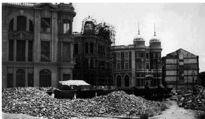
Figura 1: Construção da Praça Rio Branco
