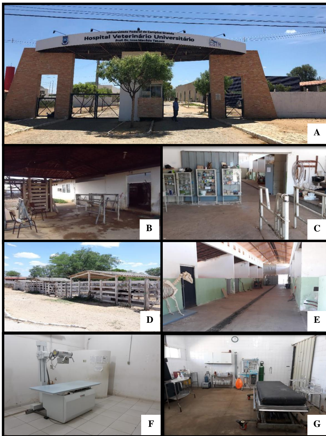
Figura 1- Setores do HV/CSTR/UFCG – campus Patos-PB. Hall de entrada do Hospital Veterinário (A); ambulatório clínico de grandes animais (B e C); piquete (D), baias de internamento de grandes animais (E), sala de diagnóstico por imagem (F) e bloco cirúrgico (G).
