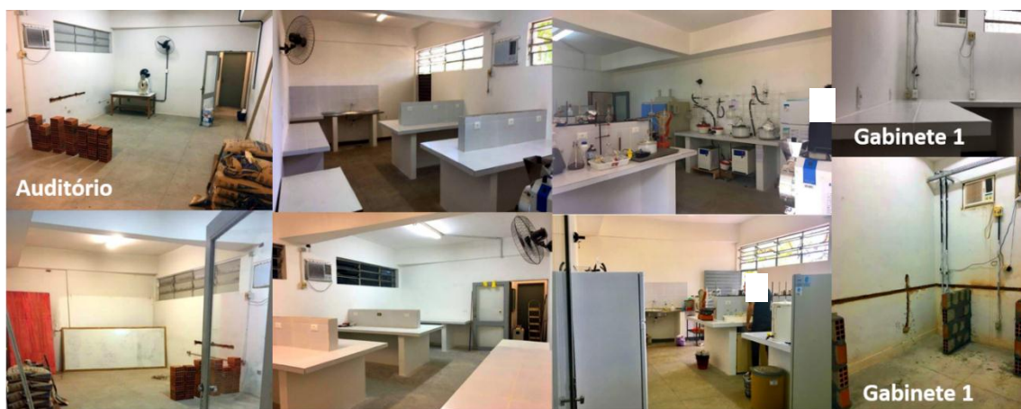
Figura 24. Reforma nos espaços: auditório e Gabinete 1.
