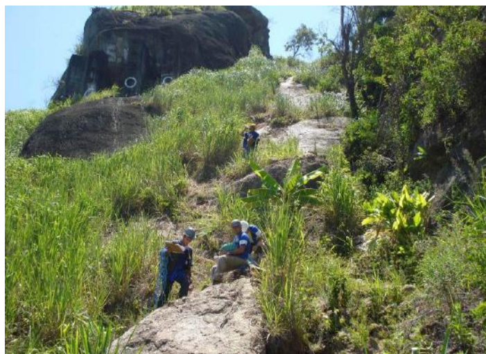
Figura 7: Ponto de obra em encosta na Grota do Surucucu.
