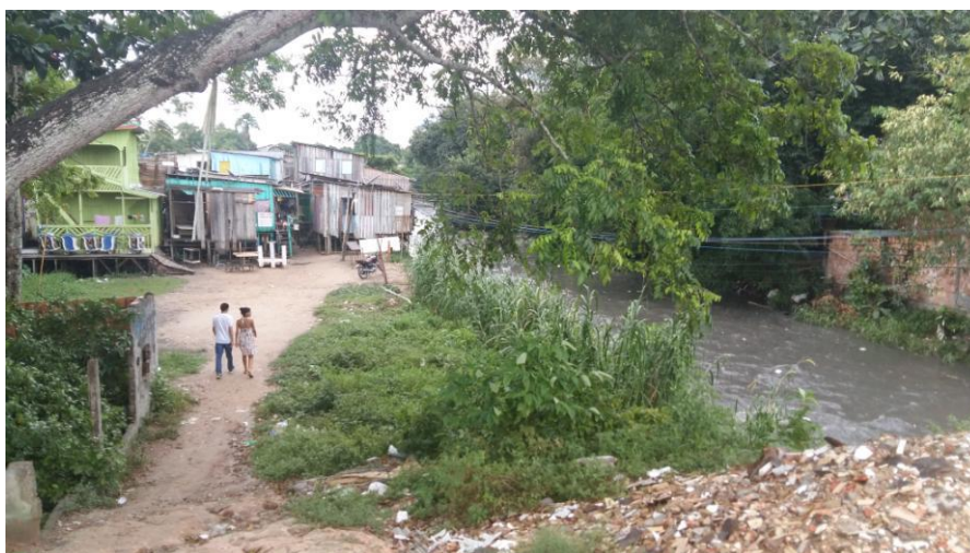
Figura 1: Residências nas margens alagáveis do Igarapé dos Franceses na cidade de Manaus - AM, o qual se encontra poluído estando seu curso d'água composto de detritos disposto no leito destes contribuindo para sua poluição, tais como restos de resíduos de construção civil e sacolas plásticas com resíduos domésticos e pets .
