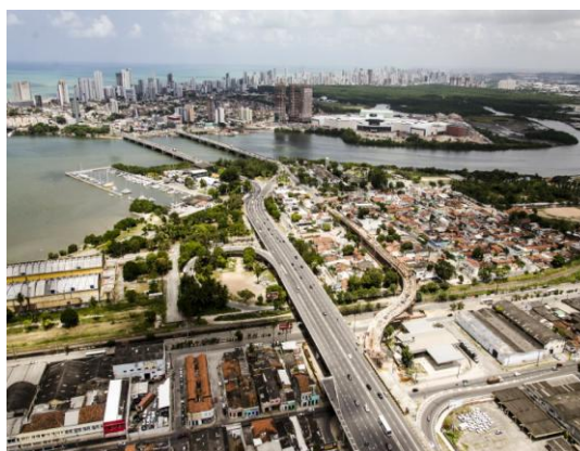
Figura 7. Construção Via Mangue
