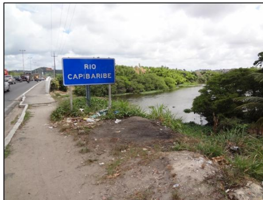
Figura 6. Inexistência das barreiras de proteção.
