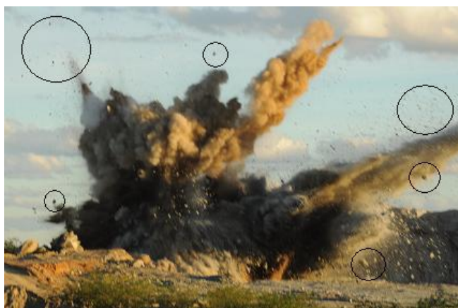
Figura 2: Ultralançamento e poeira proveniente do desmonte de rocha com explosivos
