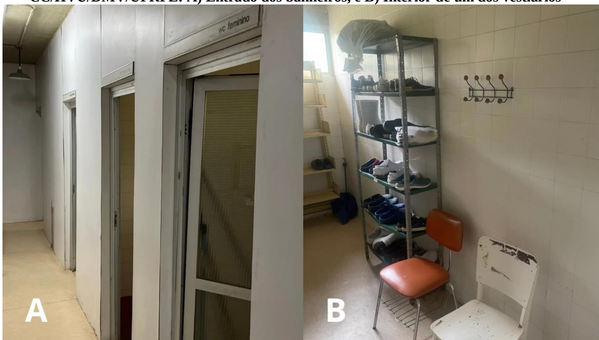
Figura 7- Imagem fotográfica: Corredor de acesso à área não crítica do CC/HVU/DMV/UFRPE: A) Entrada dos banheiros, e B) Interior de um dos vestiários
