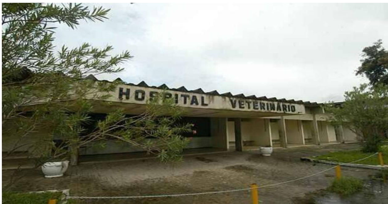
Figura 1 – Fachada da entrada do HVU do DMV/UFRPE
