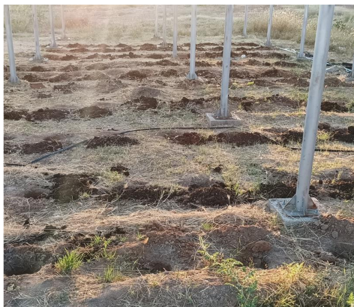
Figura 3 - Preparação das covas abaixo das placas solares. Aldeia do Serrote - Itacuruba / PE, 2023.
