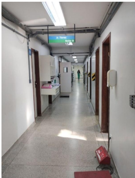
Figura 11: Corredor do HVet- PA. Fonte: Arquivo Pessoal (2025).
