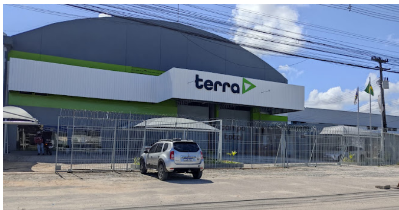
Figura 2 - Loja Terra Tecnologia Agrícola - unidade Jaboatão dos Guararapes.
