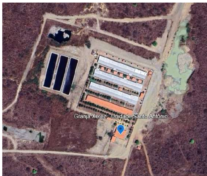
Figura 2 - Visão aérea da Unidade Santo Antônio. Fonte: Google Earth.
