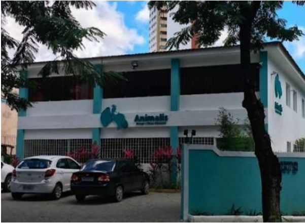
Figura 1: Fachada da Animalis - Cirurgia e Clínica Veterinária, onde está localizada a unidade Monteiro da Focus – Centro de Diagnóstico por Imagem.
