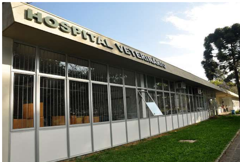
Figura 5: Fachada do Hospital Veterinário da UFPR
