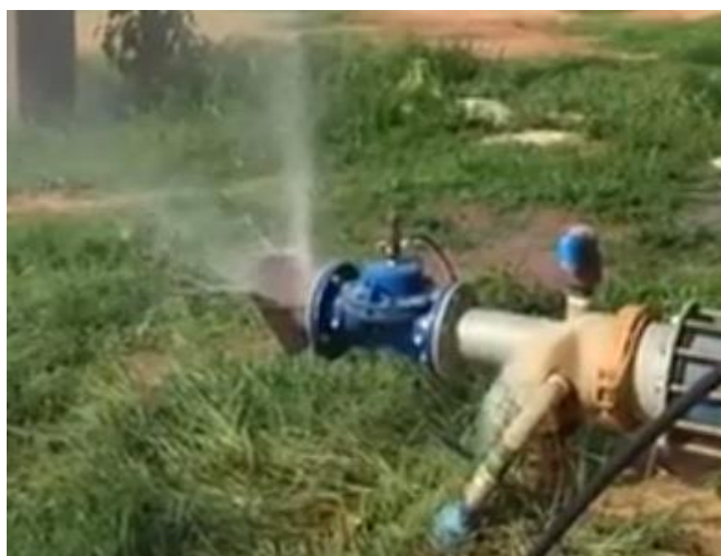
Figura 19 - Válvula de alívio atuando.
