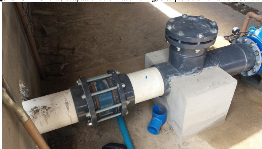
Figura 18 - À direita, adaptador de entrada no Pig, à esquerda uma válvula de retenção
