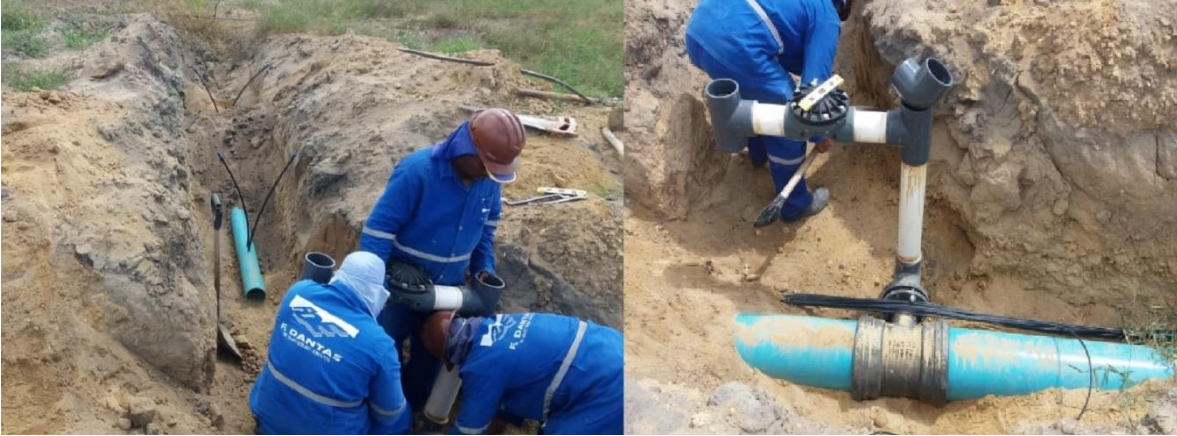
Figura 21 - Montagem do cavalete derivando da linha primária e sendo acoplado na linha secundária.
