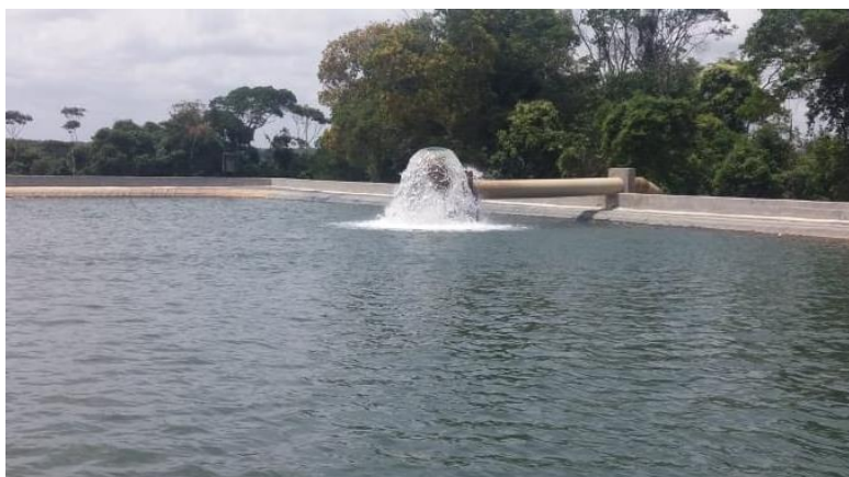
Figura 6 - Formação de "cogumelo aerador" na entrada do tanque.
