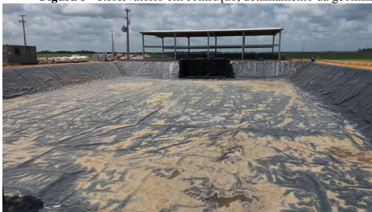
Figura 5 - Reservatório em construção, detalhamento da geomanta.
