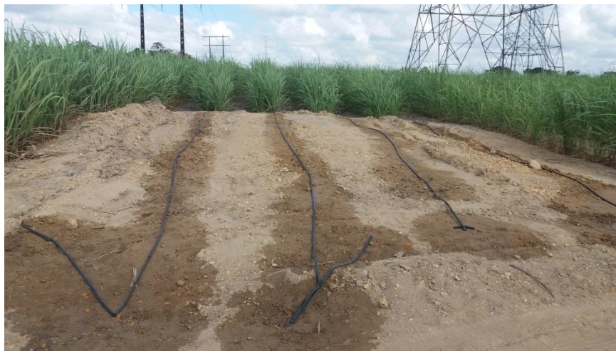
Figura 24 - Detalhe do trabalho das mangueiras desenterradas propositamente. Detalhe da sua instalação entre a fileira dupla de cana.
