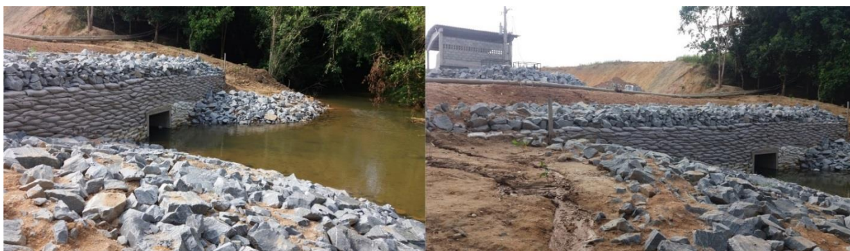
Figura 1 - Detalhes da obra civil na captação
