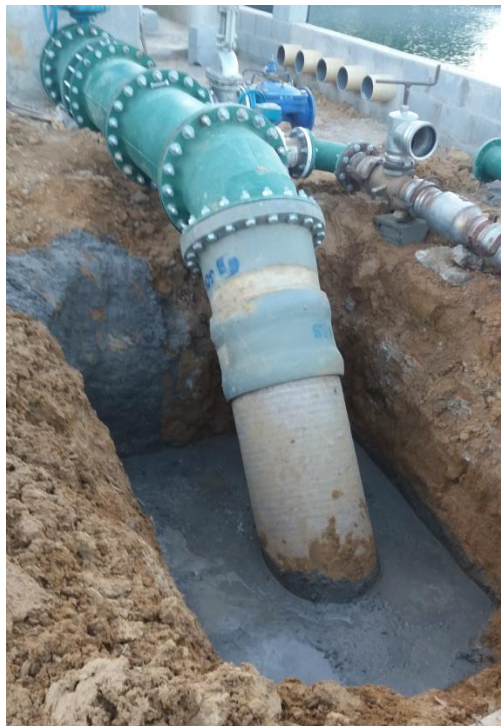
Figura 4 - Bloco de ancoragem com concreto.
