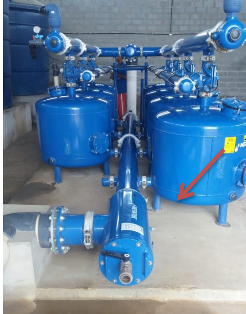
Figura 13 - Filtro de segurança: impede a passagem de areia para os gotejadores.
