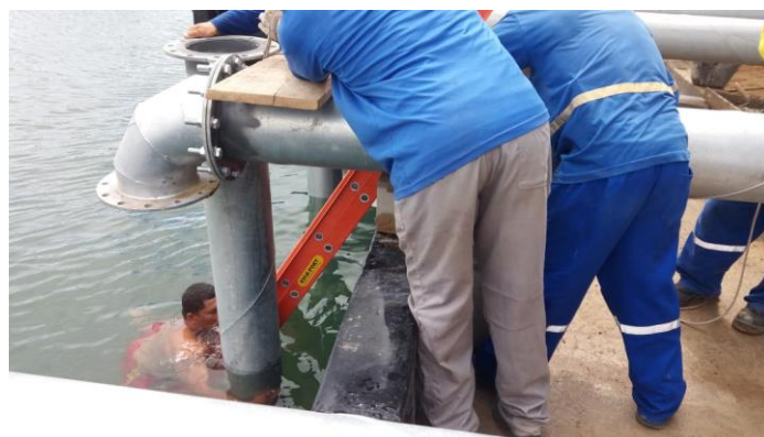
Figura 8 - Montagem da sucção, detalhe da presença de muitos homens, inclusive um mergulhador.
