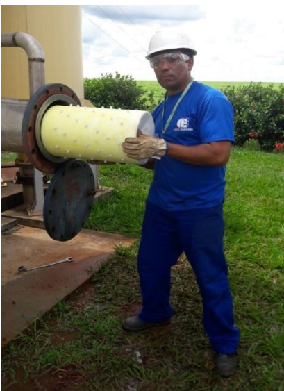
Figura 17 - Pig sendo inserido na tubulação
