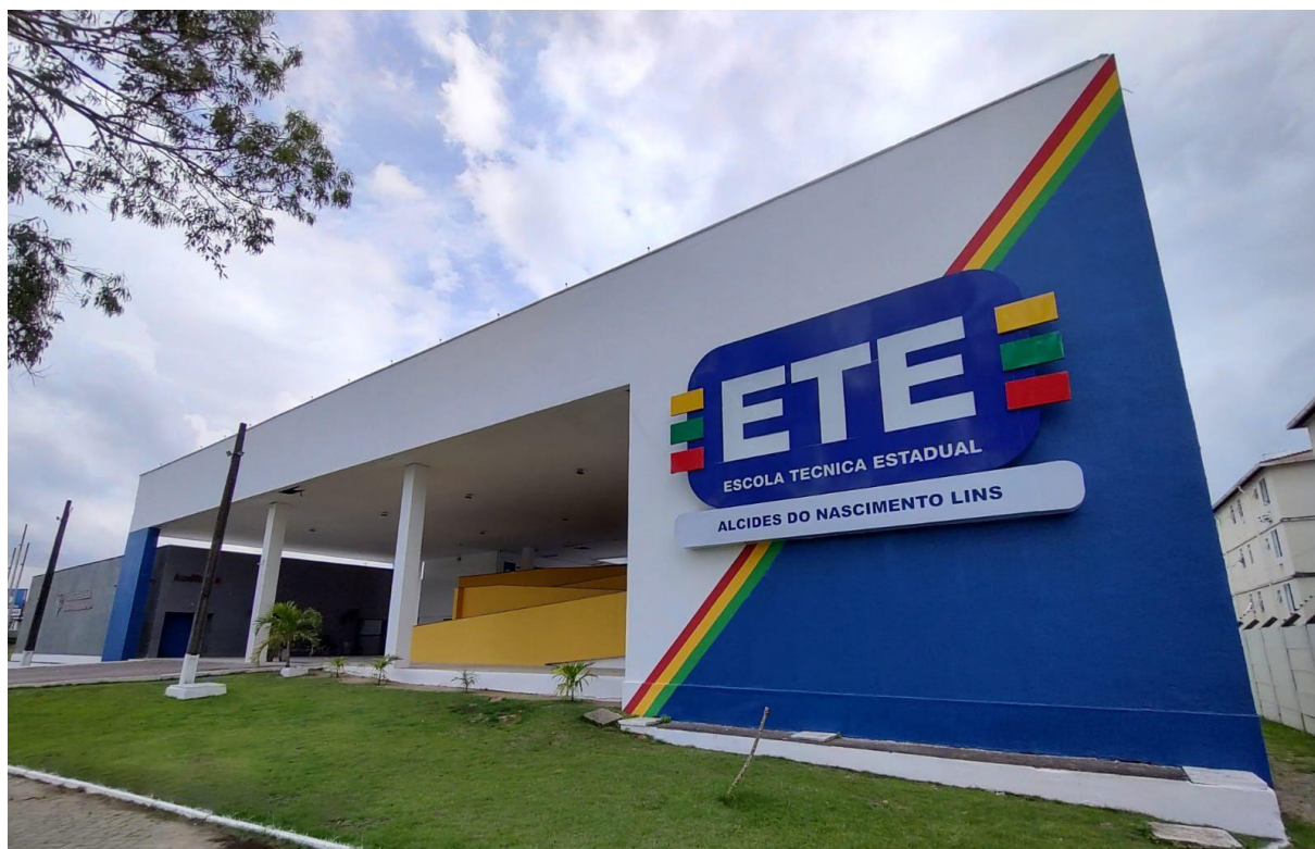
Figura 3 — Fachada da ETE Alcides do Nascimento Lins
