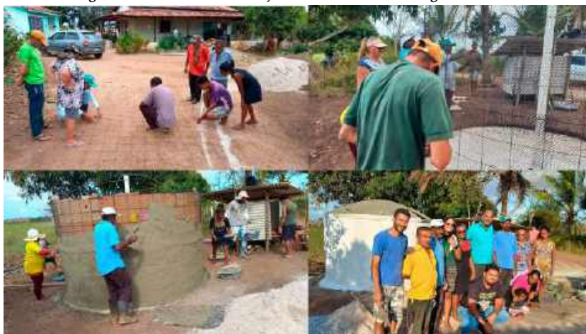
Figura 4. Processos de construção da cisterna com os/as agricultores/as.
