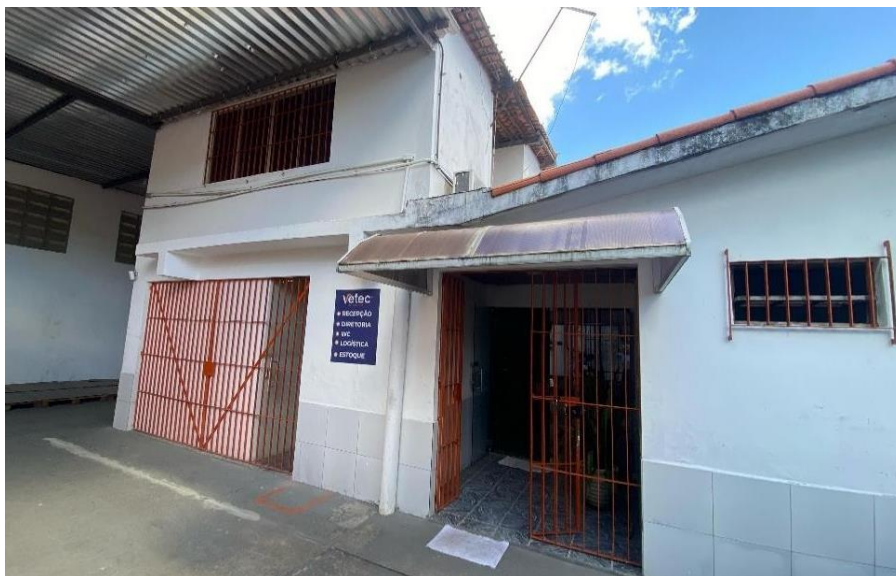
Figura 2. Vista da entrada da Vetec Distribuidora® Fonte: Arquivo pessoal (2025)
