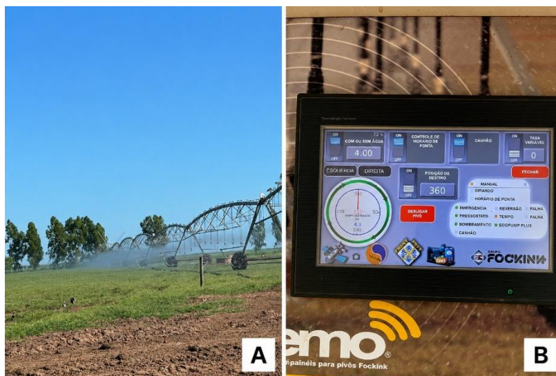
Figura 5: A - Pivô central; B - Painel de controle do pivô.
