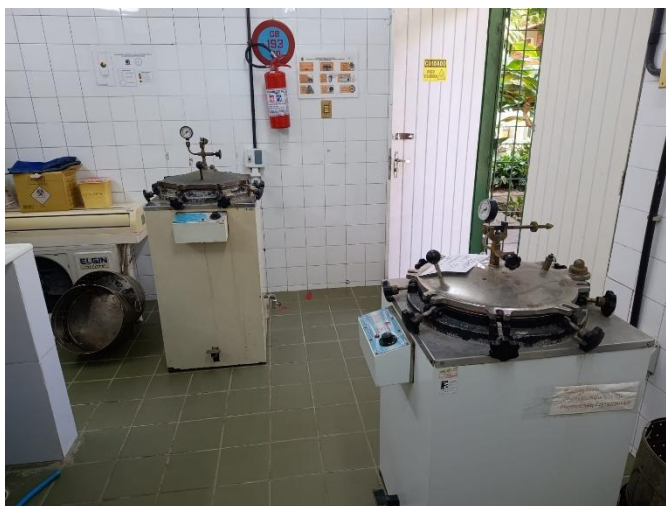
Imagem 29: Autoclaves de descontaminação e esterilização.
