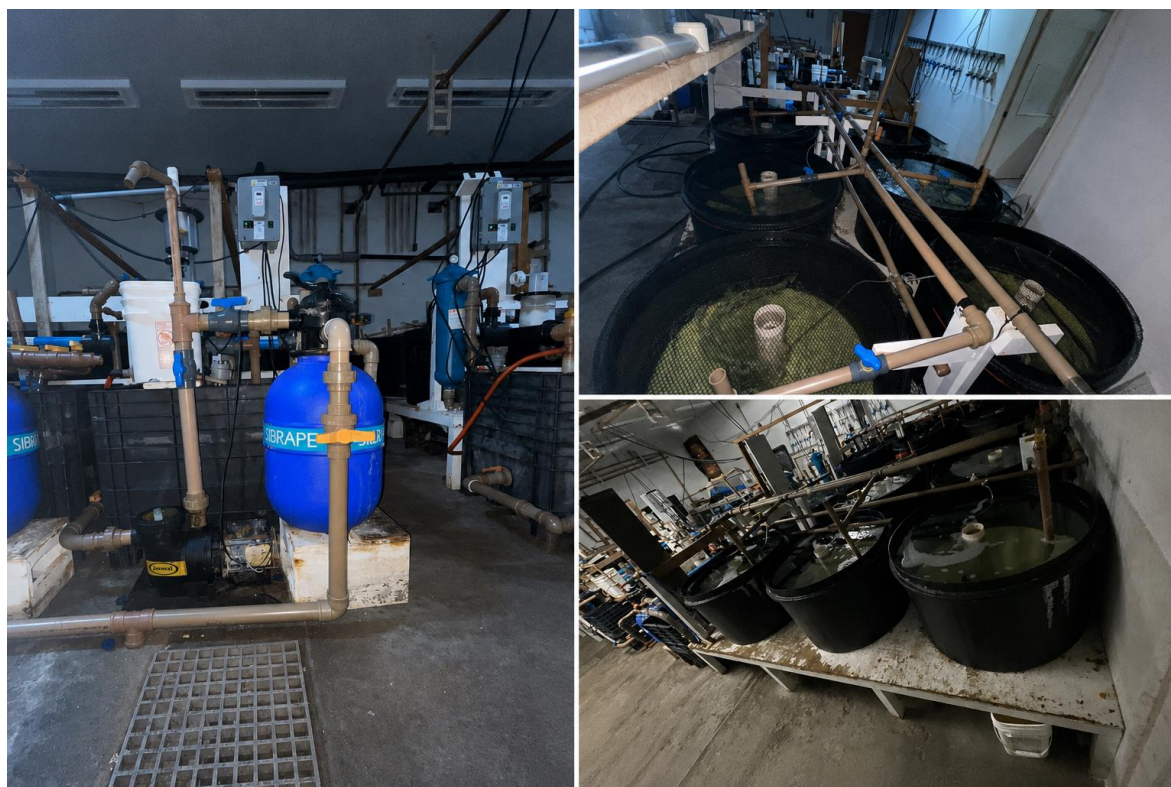
Figura 3. Estrutura do sistema de recirculação aquícola (RAS) utilizado no cultivo de Pogonias courbina .
