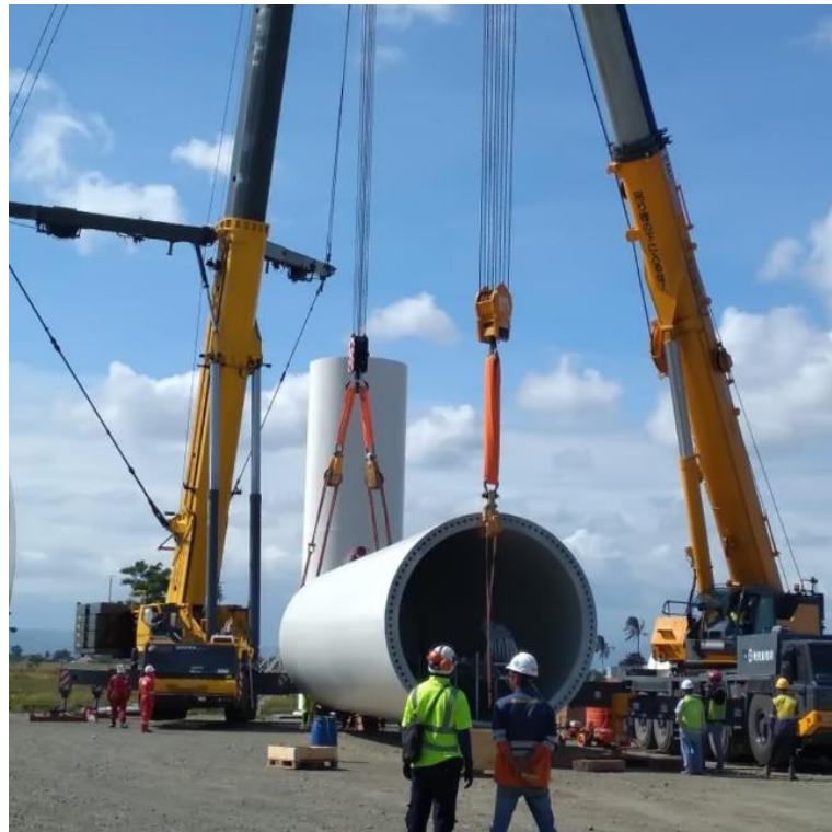
Figura 2 - Montagem de seções de torre eólica.
