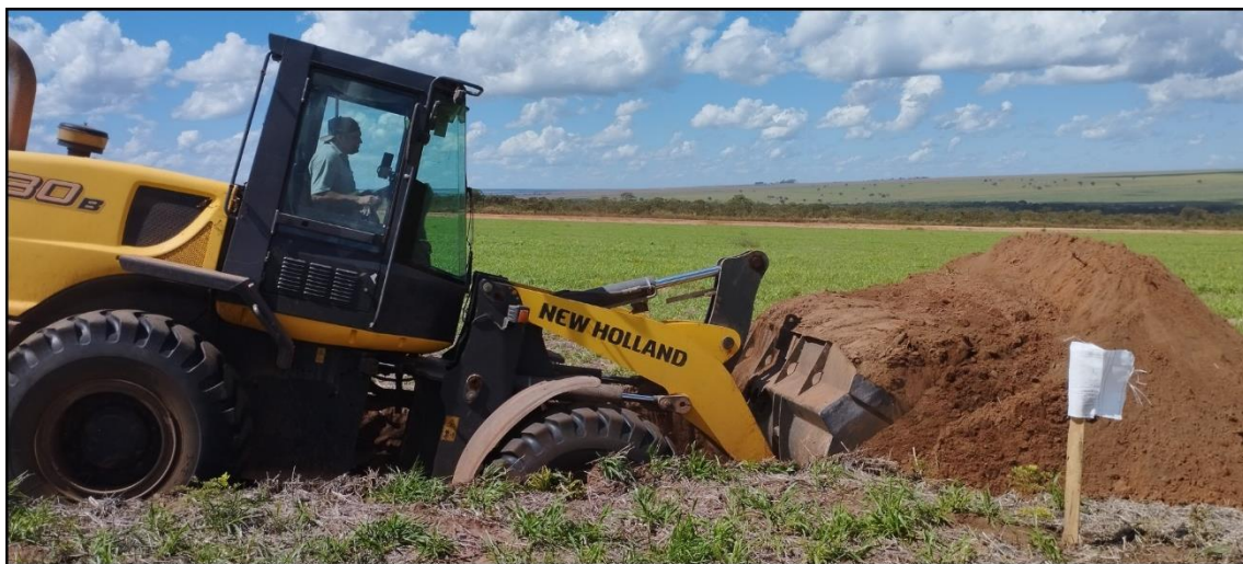
Figura 18. Pá carregadeira modelo New Holland W130B (Potência líquida de 139 cv) utilizada para escavação de trincheiras. Foto autoral.
