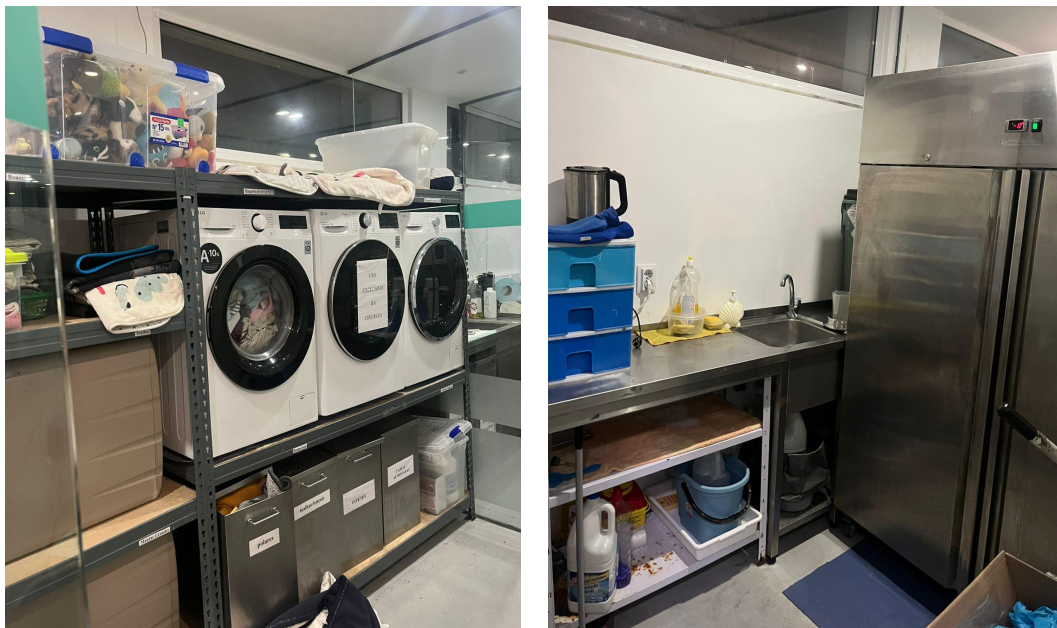
Figura 16 - Área de limpeza e desinfecção.
