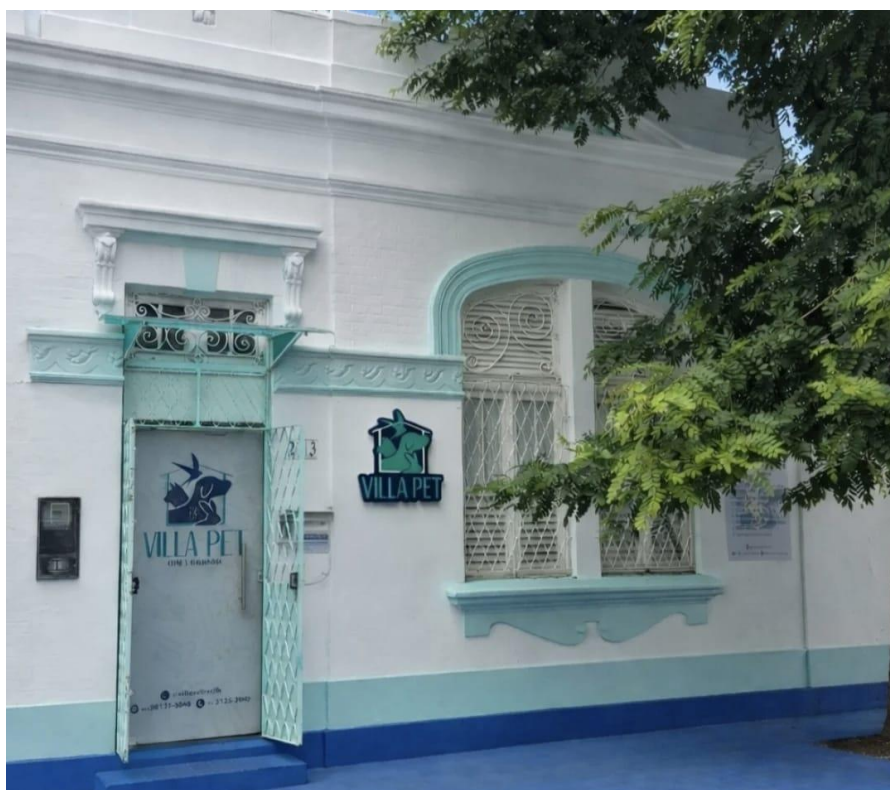
Figura 13: Fachada da Clínica Veterinária Villa Pet.
